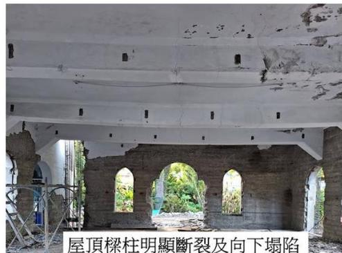
舊建築屋頂樑柱明顯斷裂及向下塌陷
